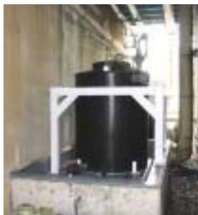
静岡工場 / 防液堤を設置したタンク
