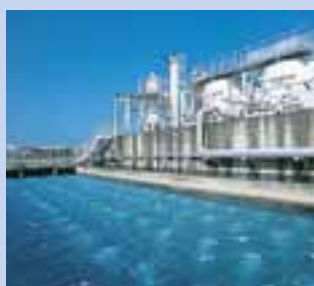
浄水処理施設
