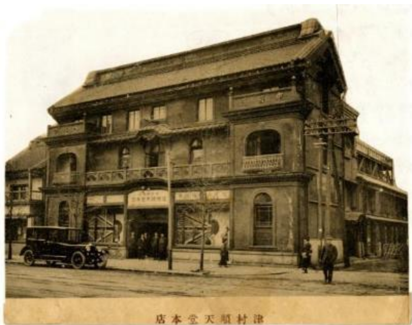
津村順天堂本店（創業当時） 東京都中央区日本橋
