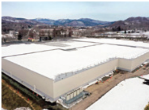
夕張ツムラ生薬保管倉庫
