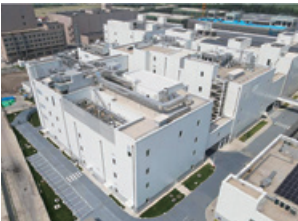
天津工場第1期製造棟
