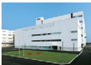
静岡工場事務QC棟
