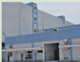
增设的生药保管仓库
