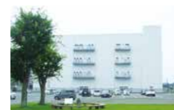
静冈工厂生药仓库
