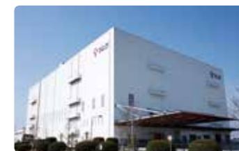
石冈中心生药大楼
