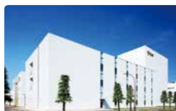
茨城工厂第二造粒大楼
