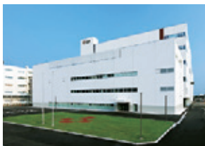
静冈工厂QC办公楼
