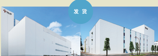
静岡工厂 (静岡县藤枝市)
