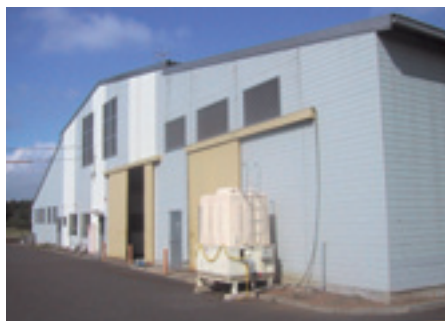
リサイクル堆肥化施設
