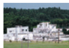
排水処理施設
