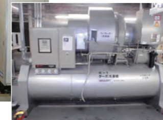
ターボ冷凍機 (研究所)
