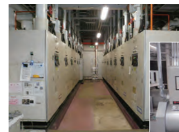
ボイラー室 (茨城工場)
