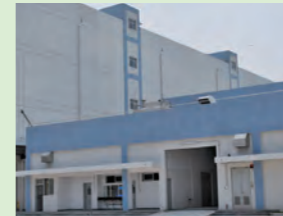
増設した生薬保管倉庫
