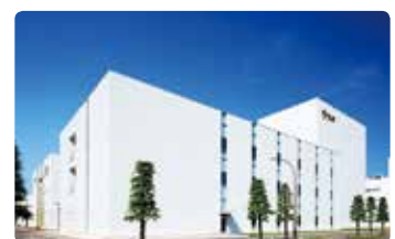
茨城工場第2造粒棟
