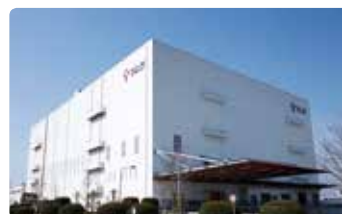
石岡センター生薬棟
